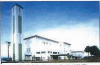
↑霞台厚生施設組合の旧ゴミ処理施設
