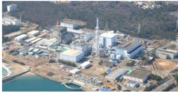
再稼働に向けて防潮堤の建設が進む東海第2原発
